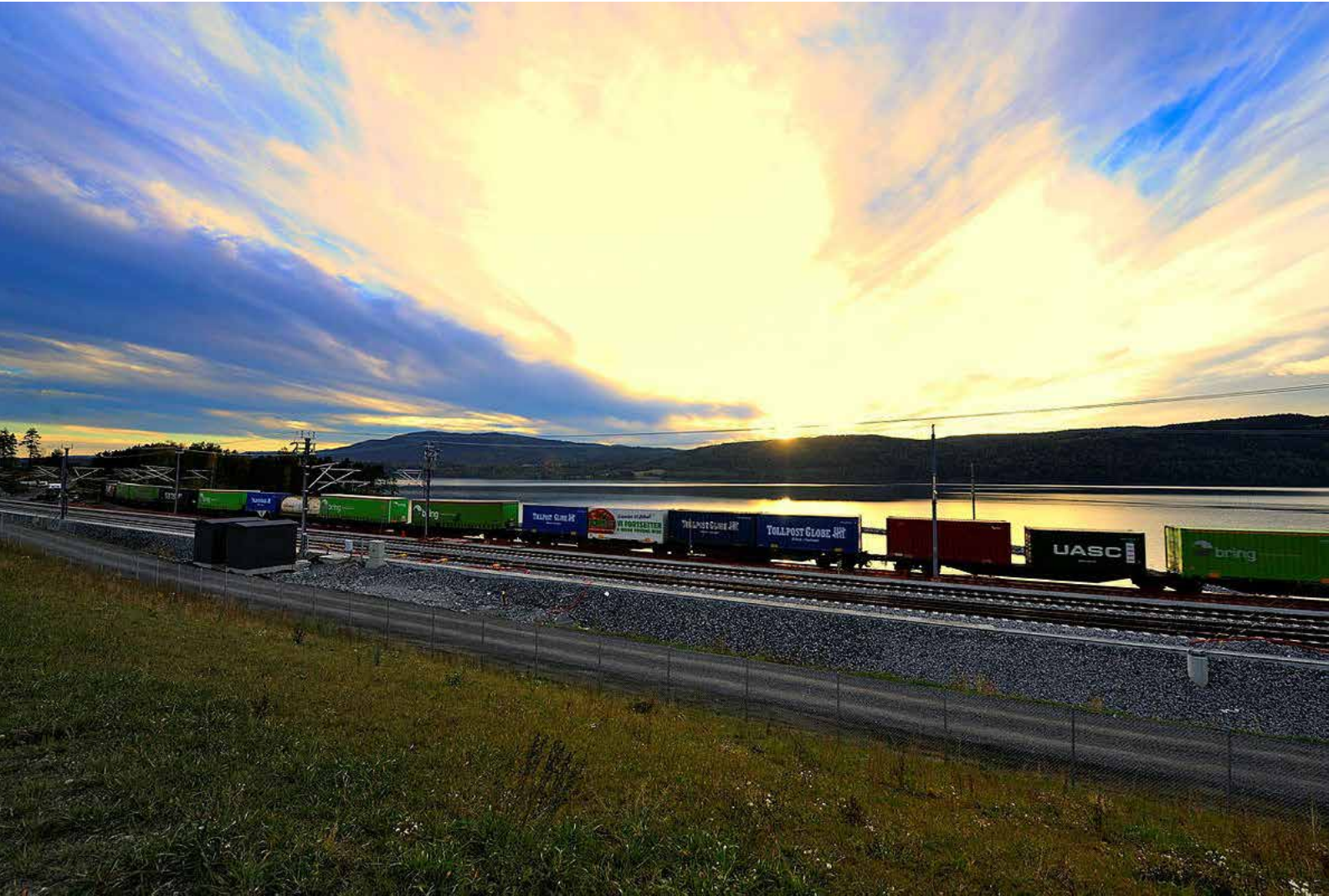
Figur 6.13 Godstog på Dovrebanen, fra Alnabru til Trondheim. Foto: Jernbanedirektoratet.
