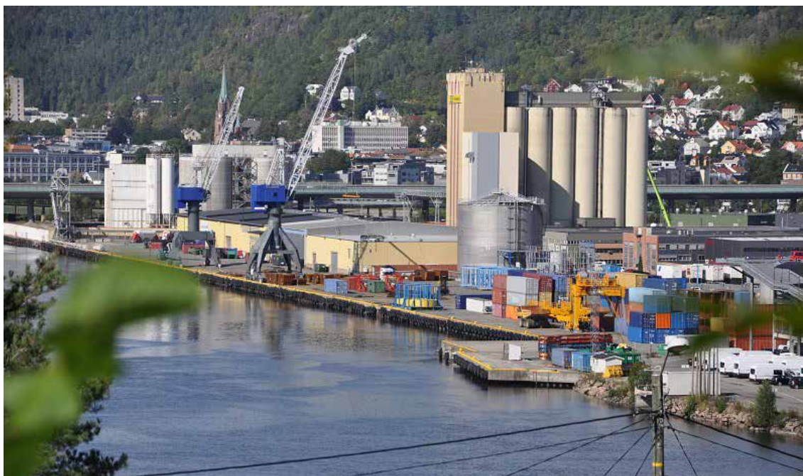
Figur 2.19 Drammen havn, foto: Kjell Wold, Statens vegvesen
