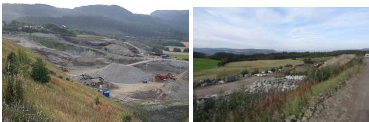
Figur 4-6 Oversiktsbilder over planområde på Torgård. Bildet t.v. er sett mot sør, mot Vassfjellet. Bildet t.h. er sett mot nordvest
