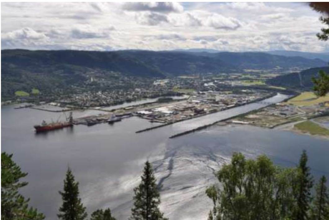
Figur 3-13 Foto Orkdal havn. Grønøra øst til venstre i bildet og området for ny havn på Grønøra vest til høyre, og til høyre for utløpet av elva Orkla.
