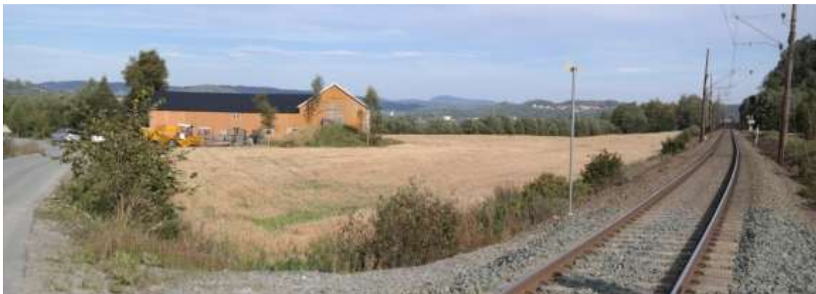
Figur 4-11 Foto av sentrale deler av terminalområdet for 2A og 2B ved planovergang over dagens Dovrebane ved Hofstad gård
