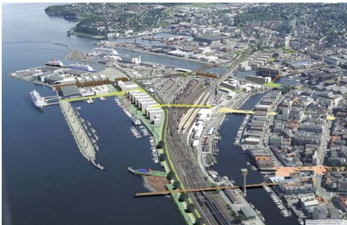
Figur 2-1 Oversikt Brattøra Trondheim
