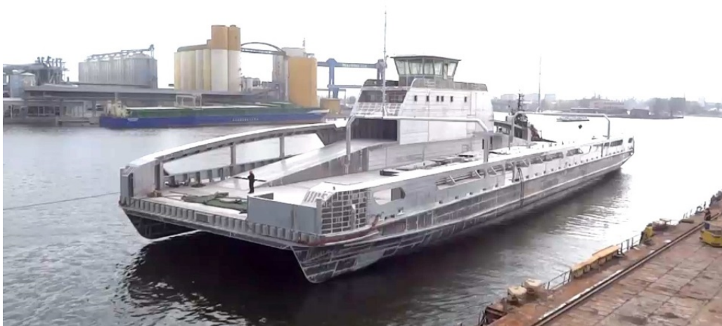
Figur 10: NorLed fergeløsning (Siemens), 2 \times 500 kWh (150 kVA), tilsvarende 1 MWh elektrisk energi lagret. Skroget til batteriferja som skal settes i drift over Sognefjorden ved årsskiftet 2014/15, her på slep fra verftet i Gdansk (Polen) til Omastrand der den skal utrustes [13].
