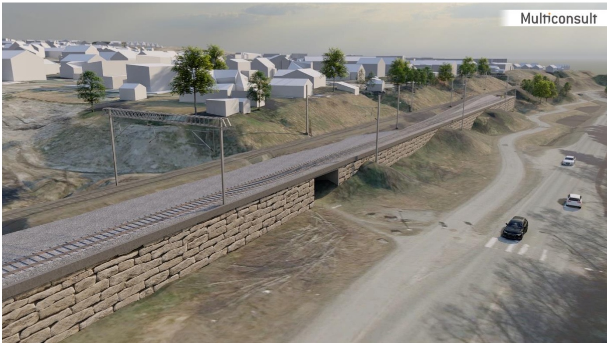
Figur 10 - Spor 1, 4 og 5 Heimdal st. nord. Utvidelse av gangkultvert under banen
