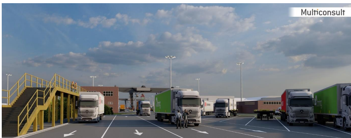
Figur 29 - Snøryddingsrampe og oppstillingsplasser
