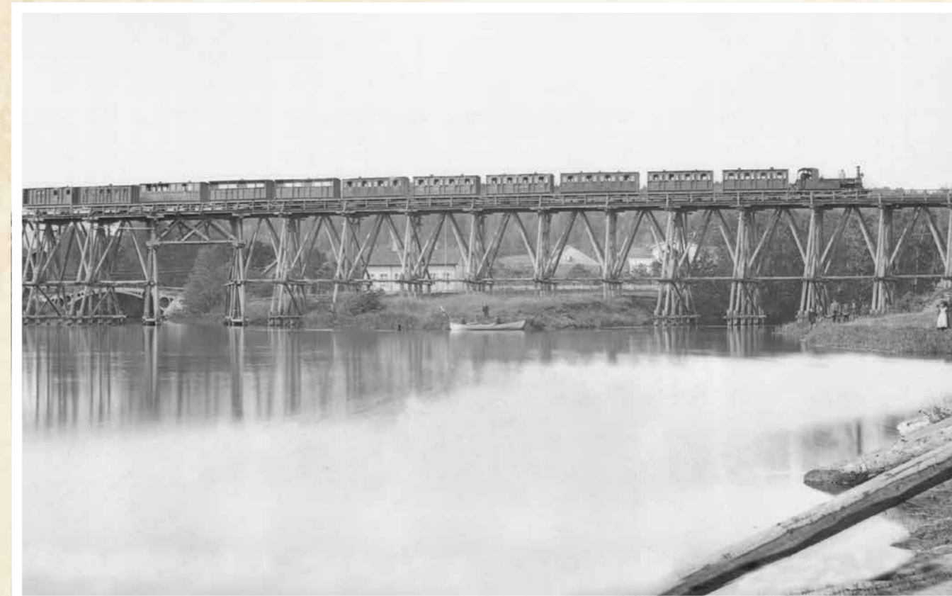
I 1873: Fra Christiania–Drammenbanens første tid. Et langt persontog poserer på Sandvikabrua om lag et år etter åpningen i 1872. I 1888 ble denne peleåkrubrua erstattet av en jernbru.
