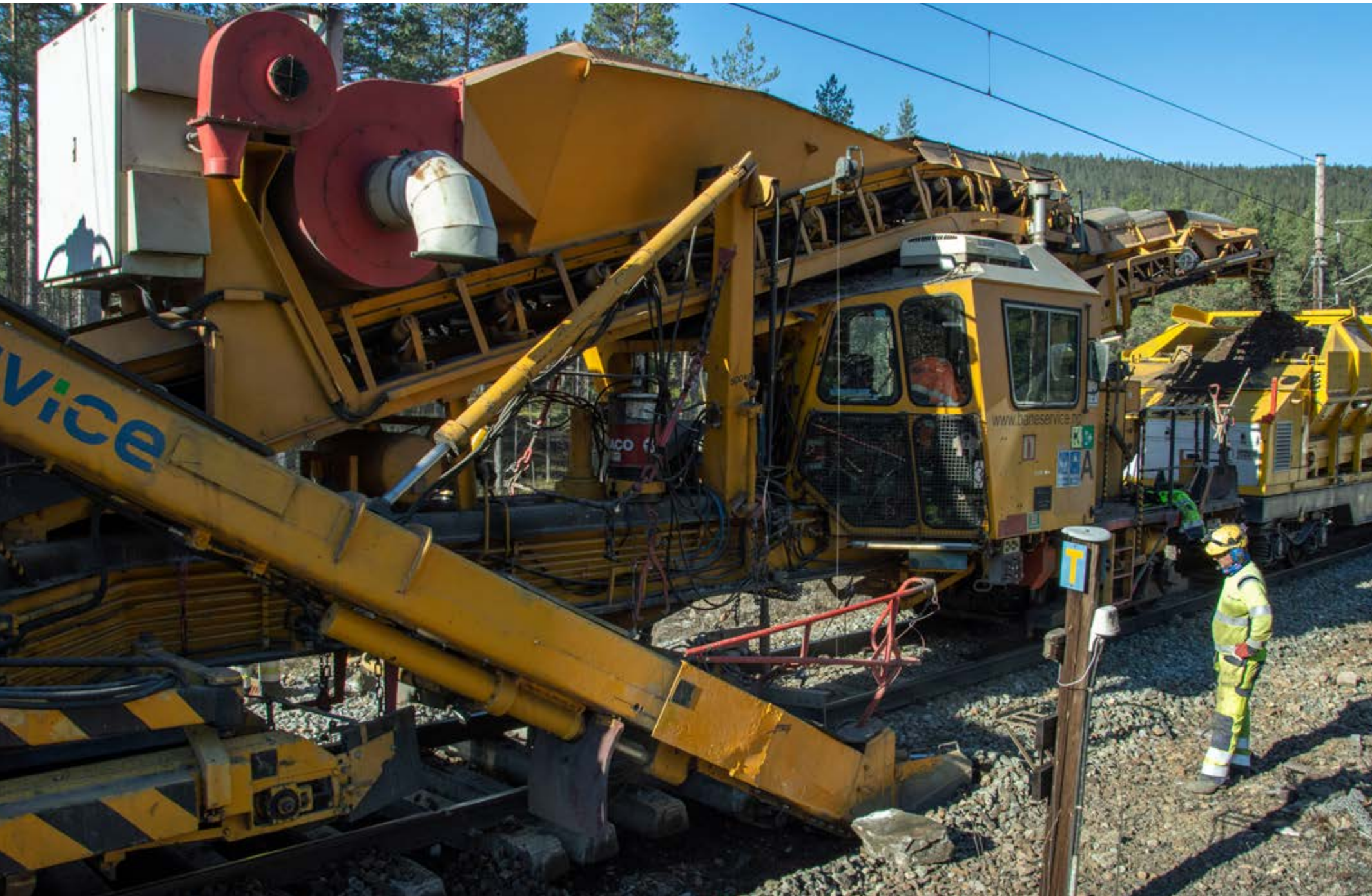
ARBEIDSHEST: Dette ballastrenseverket gjør jobben når sporet skal fornyes, gammel pukk fjernes og ny legges på.
