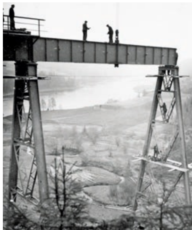
BRULAGET: Her bygges Trollalden viadukt som ble åpnet i 1938. Brua nord for Trofors stasjon ble, som mange andre jernbanebruer, bygd av brulaget til NSB. Hensynet til helse, miljø og sikkerhet var tydelig ikke det samme som i dag.
