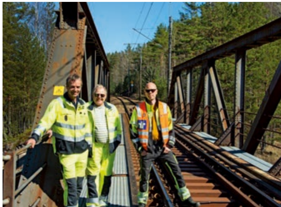
BRUFORNYERE: Fra venstre Arne Bujordet, Ingar Uldal og Knut Solhaug på bru over Retelva ved Fidjetun. Brua er eneste sted i landet det gjøres forsøk med sviller av kompositt. Vellykket, men for dyre sviller er dommen så langt.
