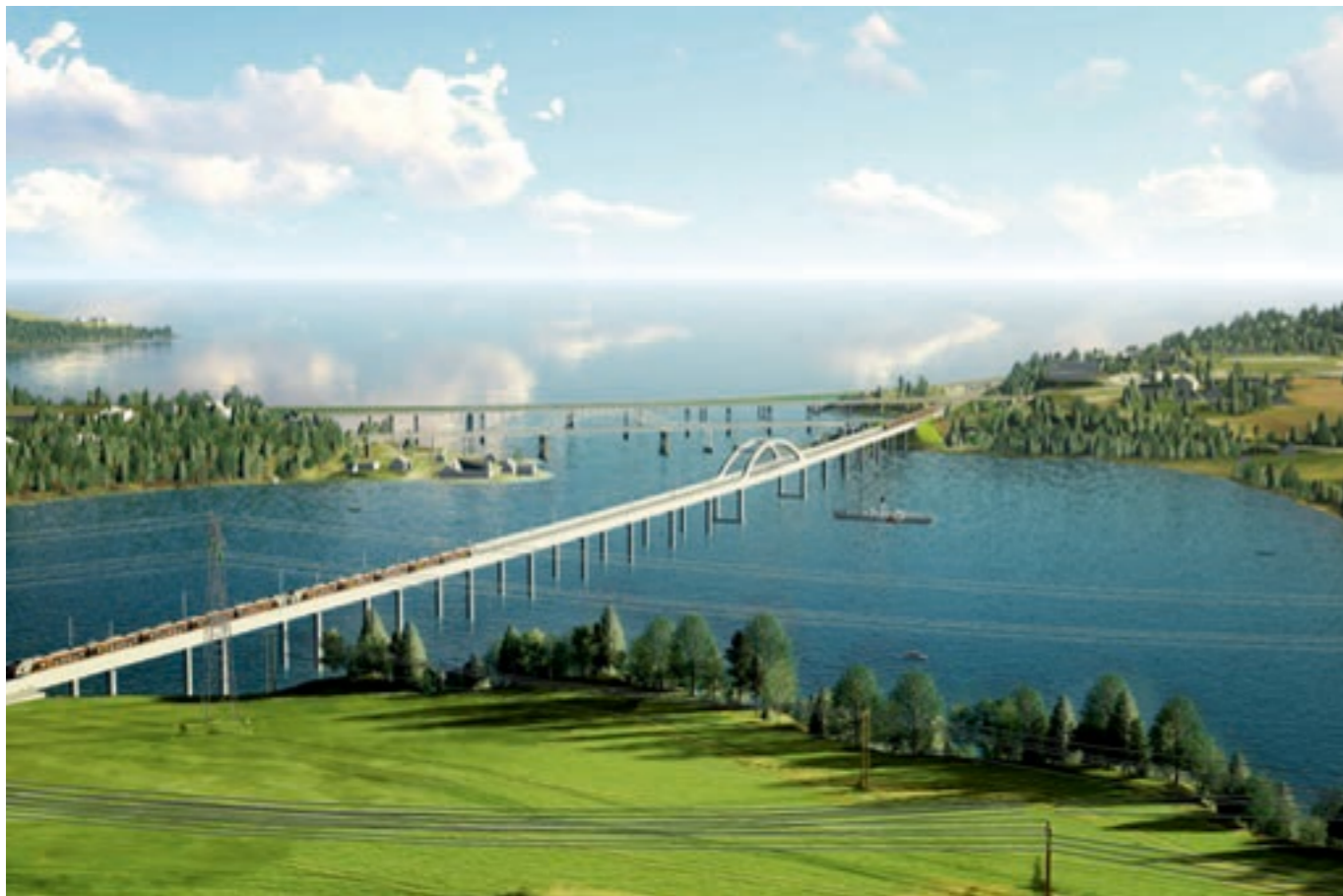
15 METER HØY: Nye Minnevika jernbanebru blir ikke bare Norges lengste. Hovedspennet bygges med en frihøyde på 15 meter for å sikre at verdens eldste hjuldamper, Skibladner, kan passere.
