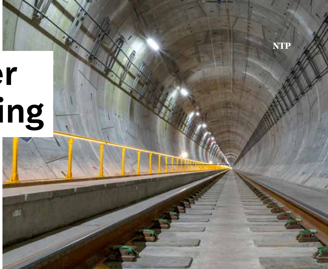
↑ TOPP MODERNE: I Blixstunnelen på Follobanen som åpner senere i år, blir nettdækningen i toppklasse. Nå vil Jernbanedirektoratet prioritere bedre nettdækning på hele jernbanenettet fram mot 2027. Foto: Øystein Grue
