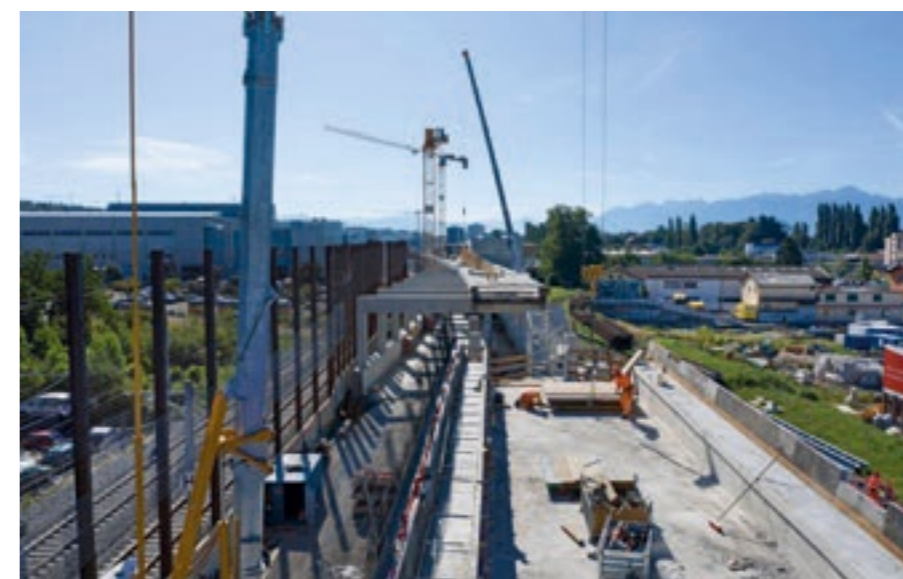
OVERGANG: Store konstruksjoner bygges mens det er full togtrafikk på banen.
