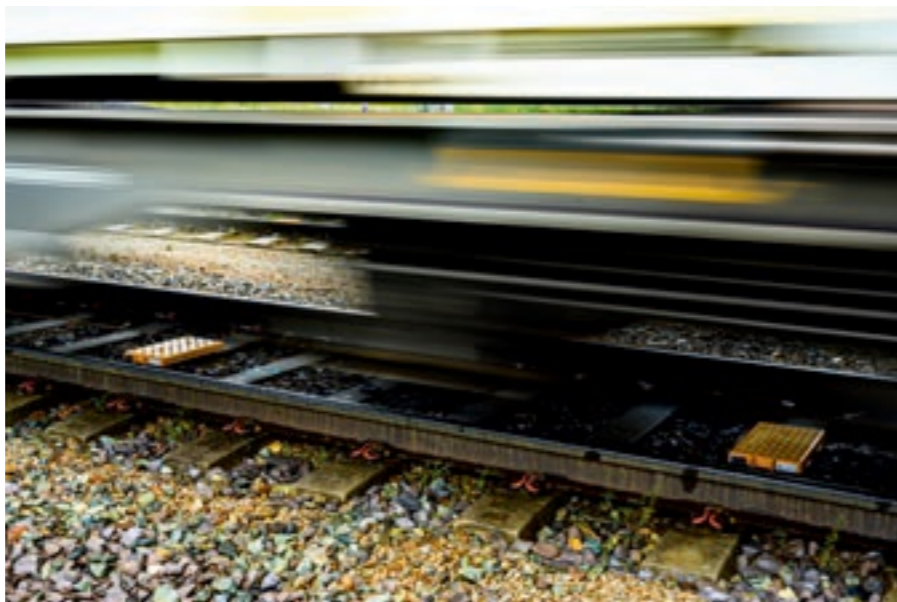
TESTER: Baliser (radiosendere) er montert i sporet mellom Roa og Hønefoss, for å teste ut det deler av det nye signalsystemet som skal bygges i Norge.
