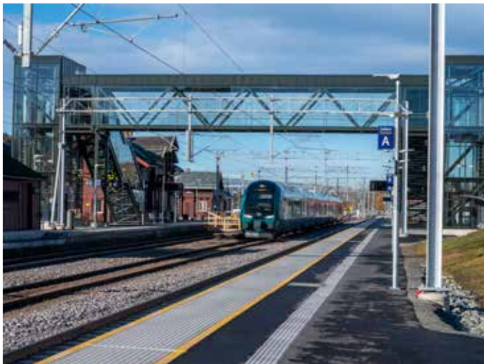
↑ JAREN er snustasjon for togene i L3-pendelen. Stasjonen har i tillegg til nye plattformer også fått nytt hensettingsanlegg for seks togsett og ny driftsbasis for vedlikeholdet av banen.
