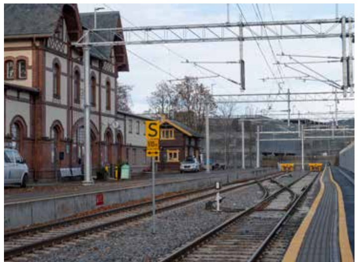
↑ GJØVIK STASJON har blant annet fått ny sideplattform for spor 2 og nytt hensettingsanlegg.
