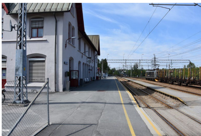
Figur 7-20 - Sarpsborg stasjon med smal og lav mellomplattform. Foto: Network Statement
