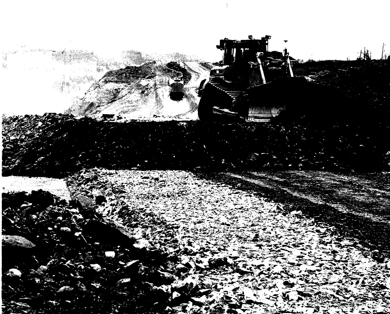
Utlegging av frostsikringslag, Gran. Foto: Frank Andersen
