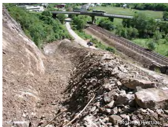
Figur 2.25 Skredsikring ved Dalegarden
