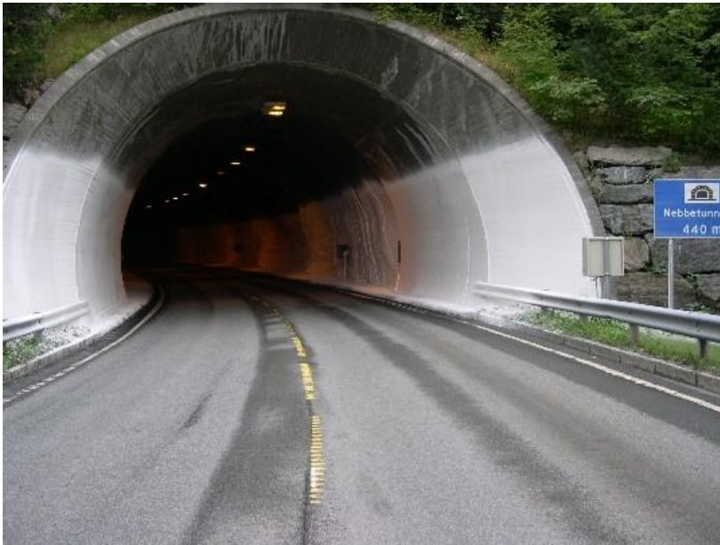
Figur 12. Kvitkalking i tunnel.
