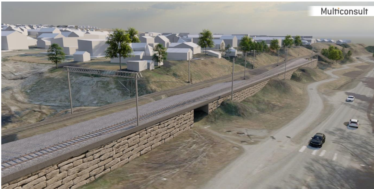
Figur 17. Spor 1, 4 og 5 ved Heimdal stasjon nord. Ny gangkulvert under banen.
