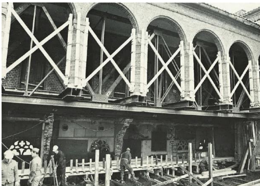
Figur 80: Midlertidig understøttelse av Basarhallene – Hentet fra NSB-teknikk nr. 1-1980, Oslo-tunnelen, teknisk beskrivelse.
