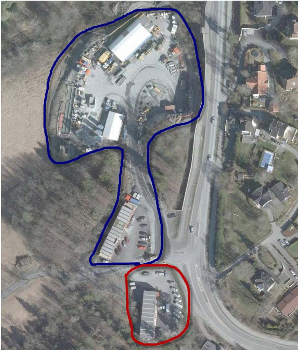
Figur 17: Riggområde for Bærumstunnelen Tverrslag Skallum samt hovedrigg byggherre 2008 Flyfoto er hentet fra Finn.kart «historiske kart»
