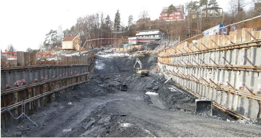
Figur 26: Byggegropp Lysaker Vest. (Foto: Geovita AS)
