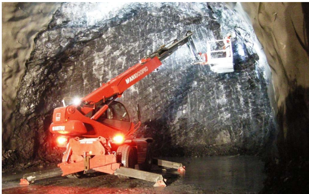
Figur 3: Løfteutstyr ved berginspeksjon på stoff i Bærumstunnelen
