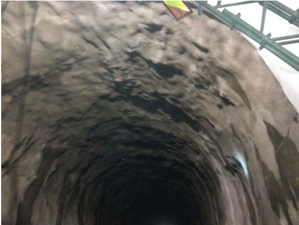
Figur 9: Tunnel sikret og utjevnet med sprøytebetong før membranmontering. Fellesprosjektet E6-Dovrebanen
