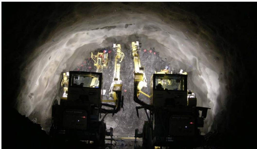
Figur 5: Boring av injeksjonshull i Bærumstunnelen. Sandvika Øst
