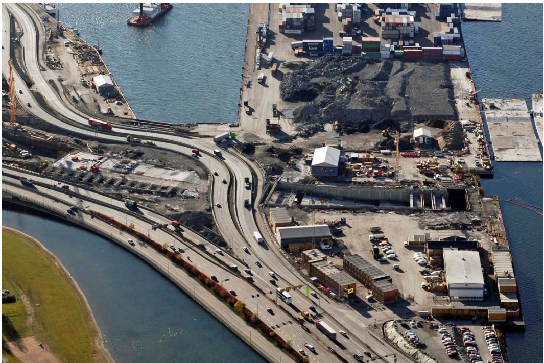
Figur 33: Løsmassetunnel Sørenga med slissevegger (Foto: SVV)
