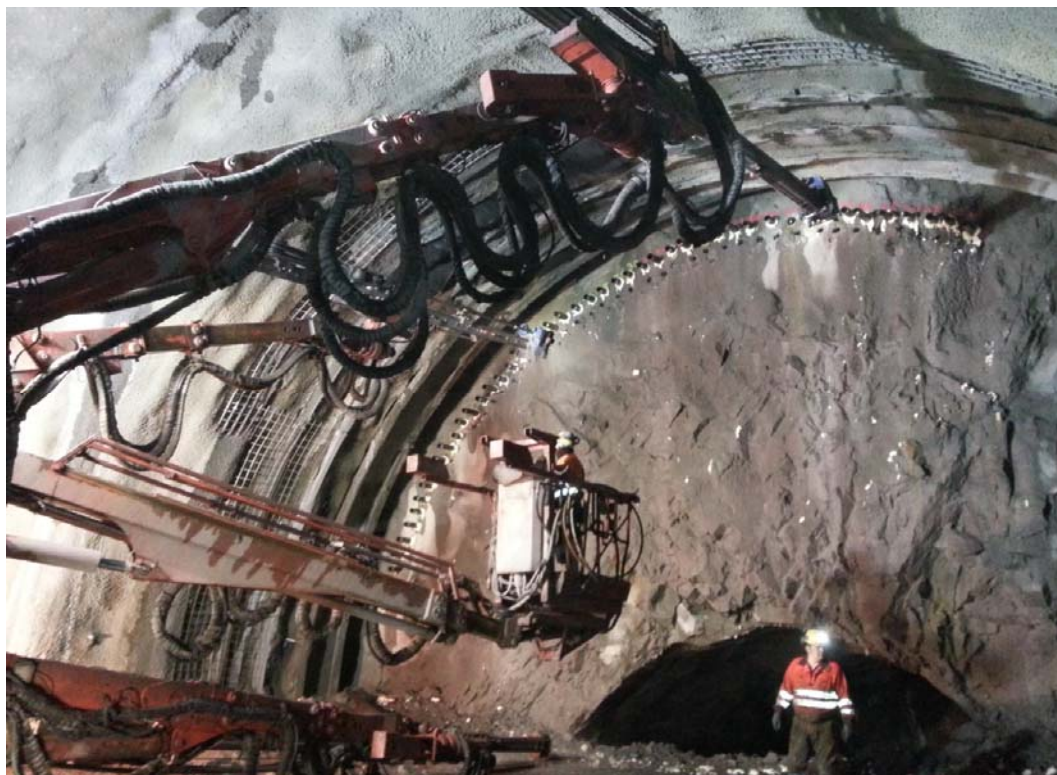
Figur 6: Etablering av rørspling ved passering av svakhetssone i Holmestrandtunnelen
