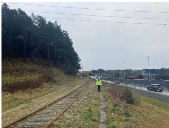
Figur 6-8: Eksisterende over- og underbygning. Bildet til venstre viser at kryssende høyspentledninger er ikke til hinder for elektrifisering av Ålgårdbanen. Bildet til høyre viser gammel overbygning ved Bråstein - kan ikke gjenbrukes, men stål kan resirkuleres (foto: Norconsult)
