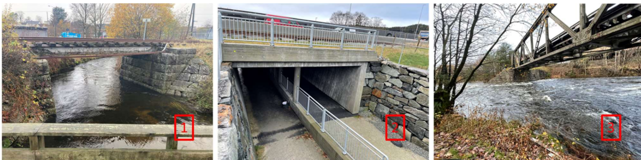
Figur 6-13: Bruer over elver, samt en gang- og sykkelkulvert (foto: Norconsult)
