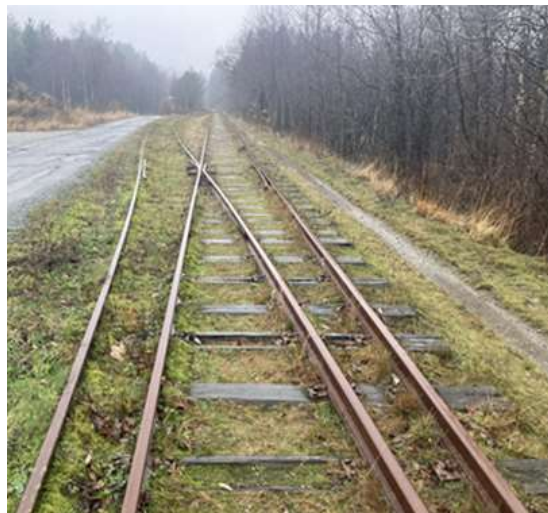
Figur 6-8: Eksisterende over- og underbygning. Bildet til venstre viser at kryssende høyspentledninger er ikke til hinder for elektrifisering av Ålgårdbanen. Bildet til høyre viser gammel overbygning ved Bråstein - kan ikke gjenbrukes, men stål kan resirkuleres (foto: Norconsult)
