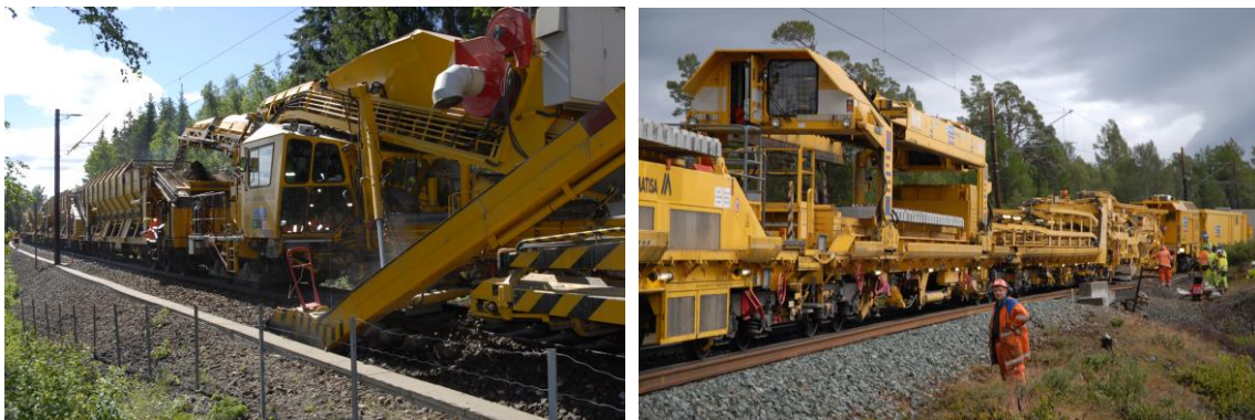
Figur 4-7 Ballastrenseverk (t.v.) og sporombyggingstog. Foto: Njål Svingheim
