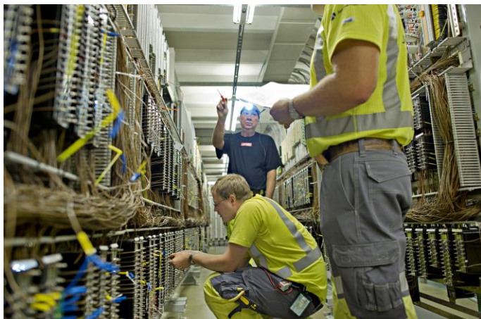
Figur 4-4 Kontroll av sikringsanlegg. Foto: Hilde Lillejord
