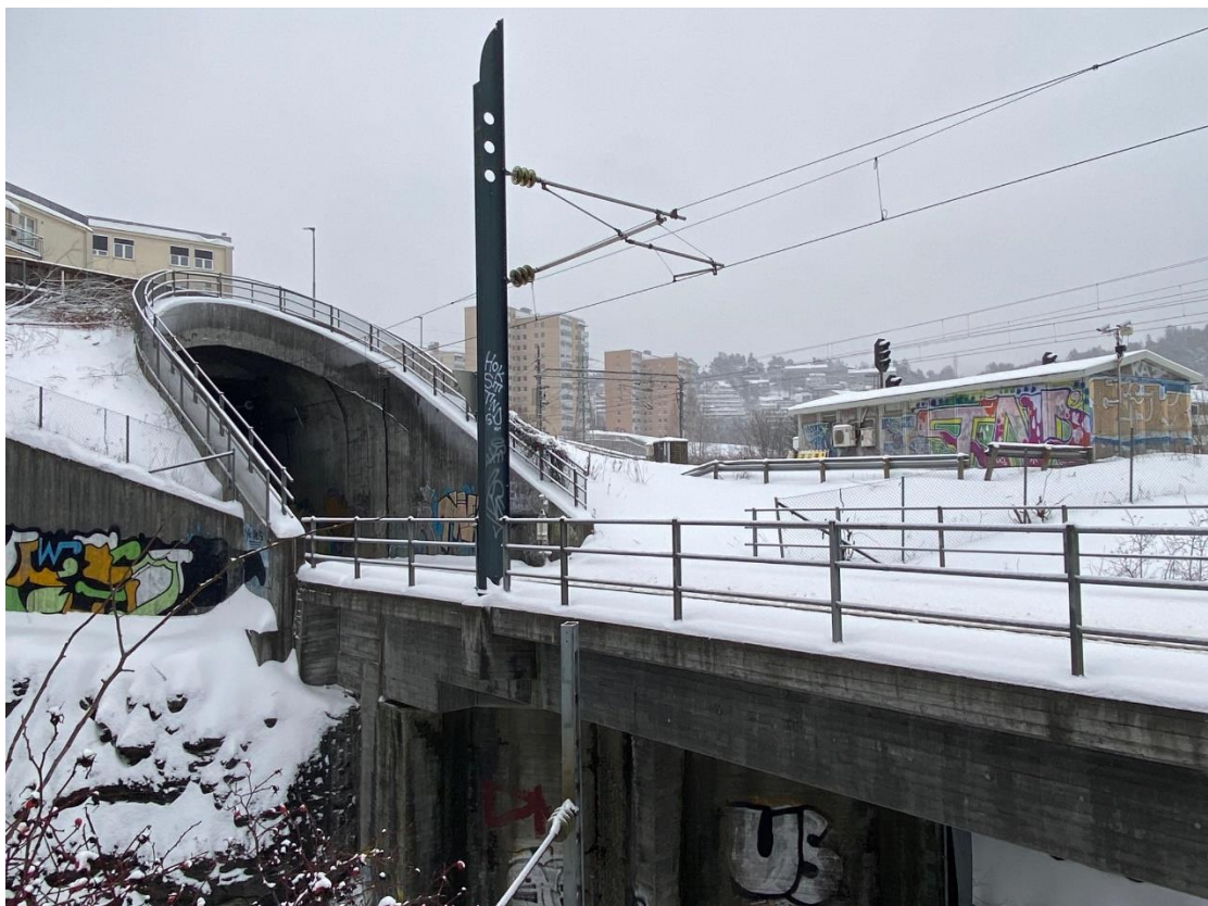
Bilde 3: Tunnelmunningen fra Rampsportet med tilgang til beredskapsplass i umiddelbar nærhet
